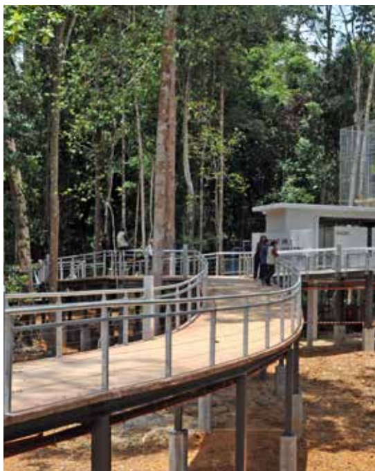
Kemudahan boardwalk di Kompleks Makmal Tasik Chini
