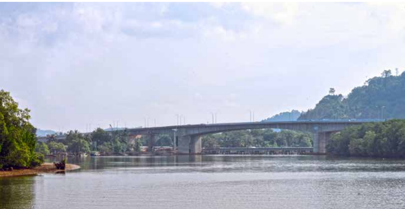
Jambatan Bukit Kuang
