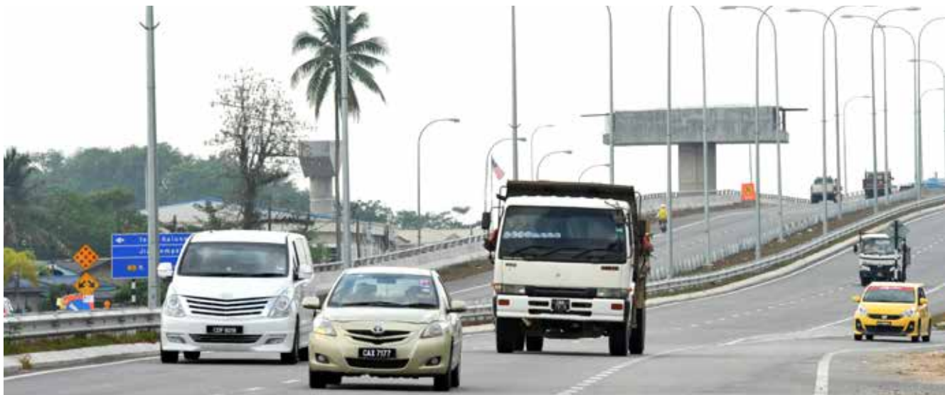
Jambatan Bukit Kuang
