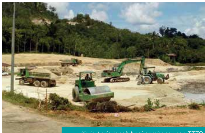
Kerja-kerja tanah bagi pembangunan TTTS
