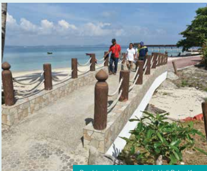
Pembinaan laluan pejalan kaki di Pulau Kapas
