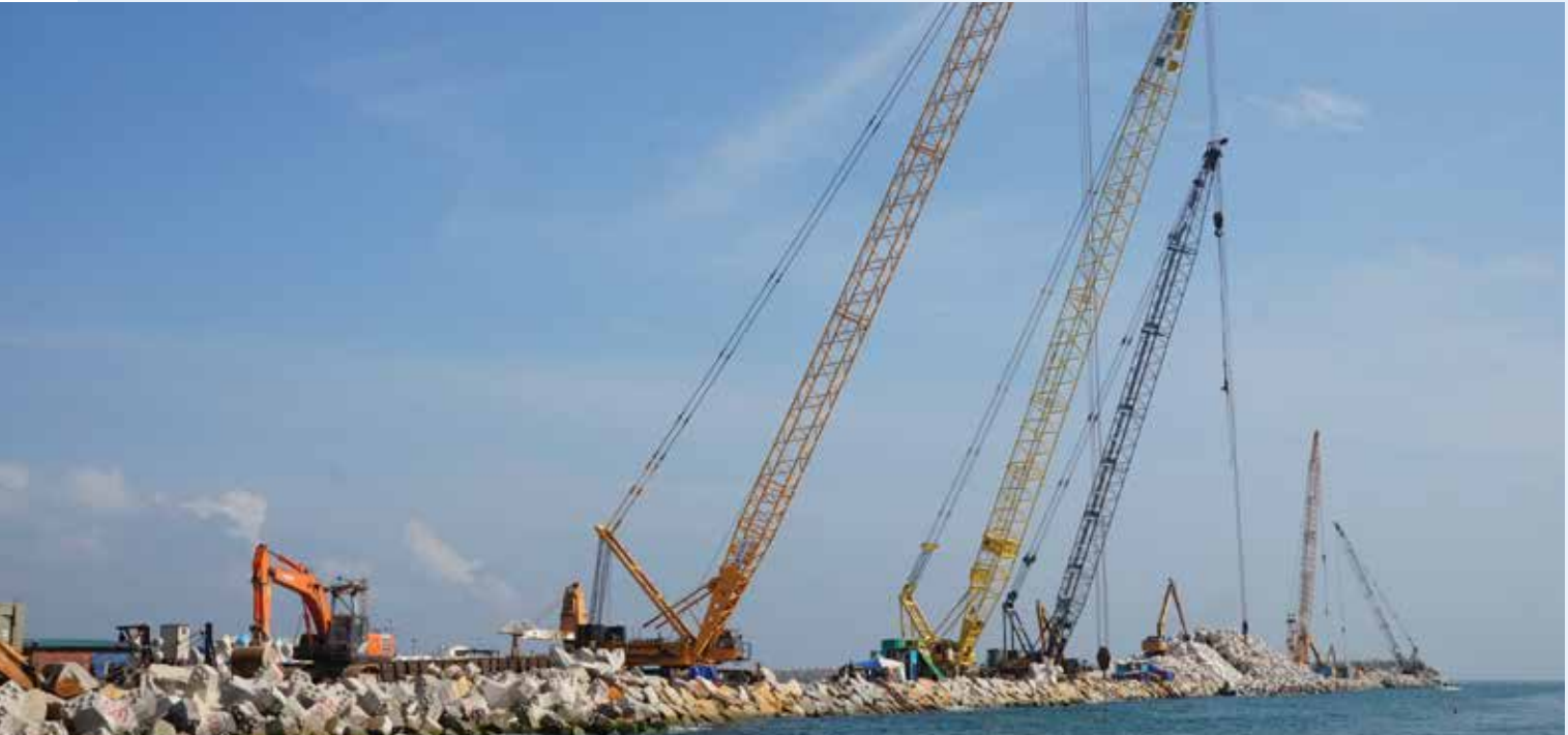
Kerja-kerja pembinaan pemecah ombak di Pelabuhan Kuantan oleh ECERDC di bawah Fasa 1A telah pun siap pada 2017, dan projek tersebut telah diserahkan kepada pihak Lembaga Pelabuhan Kuantan
